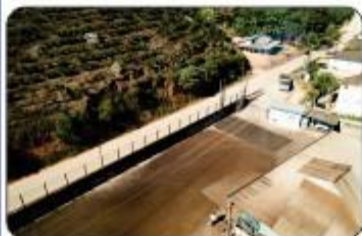
CALÇAMENTO DA VILA DO SALINO
