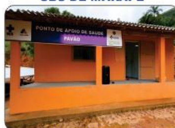
CONSTRUÇÃO DA UBS DO PAVÃO
