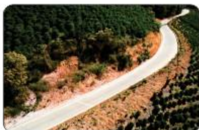
CALÇAMENTO DA SERRA DO SALINO
