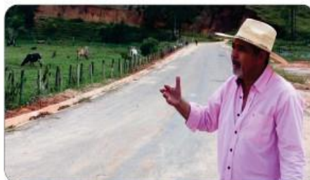
CÓRREGO SÃO DOMINGOS, PRÓXIMO A CASA DE ORAÇÃO, ONDE LIGARÁ AO NOVO TRECHO DE ASFALTO
